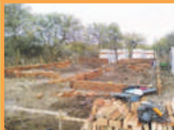
2- Mampostería de fundación
