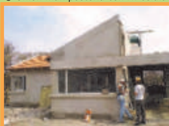
7- Revoques sobre bloques
