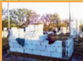
6- Mampostería de hormigón celular
