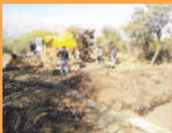
1- Llenado de cimientos
