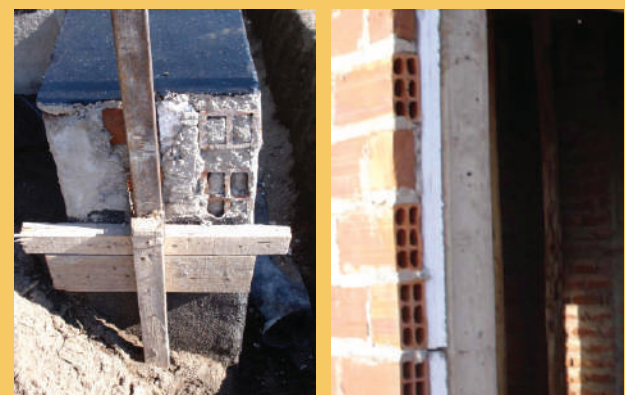
AISLAMIENTO TÉRMICO ENVOLVENTE VERTICAL
