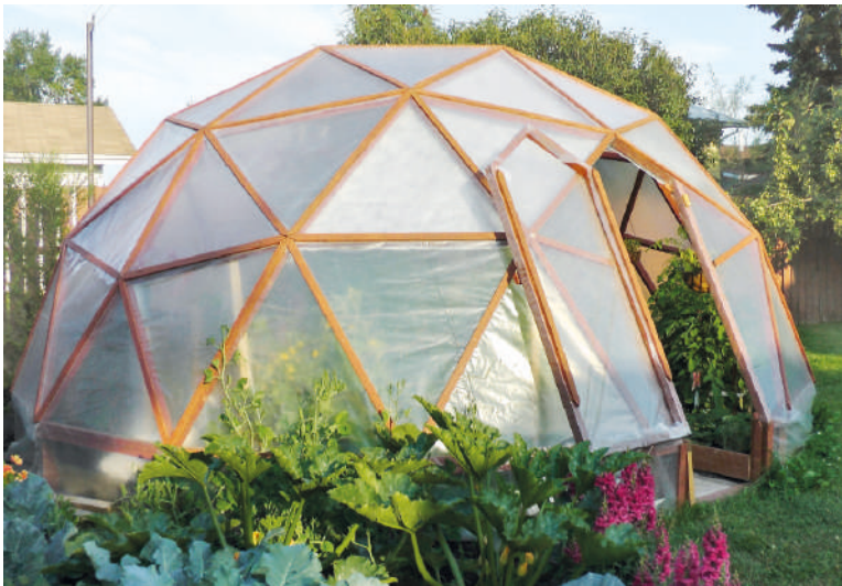
Domo de estructura triangulada y PVC de alta densidad
