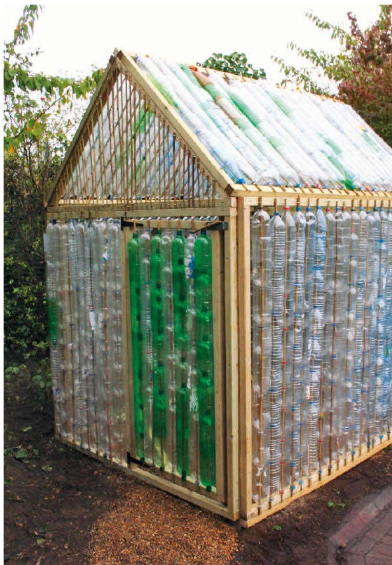
Estructura de madera y cerramientos de botellas descartables
