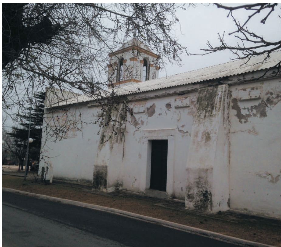
Fachada lateral, contrafuertes y profundos vanos para las pesadas aberturas.
