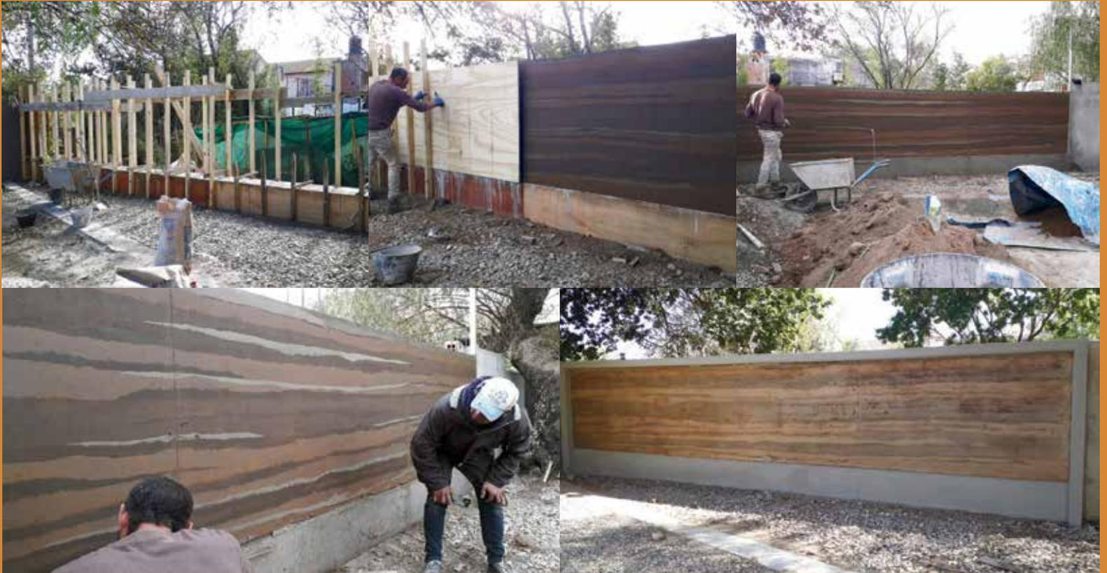
El tapial o pisa tapial es una tipología constructiva dentro de las denominadas técnicas naturales y se ubica dentro de éstas en la clasificación de monolíticas. El muro tapial consiste en rellenar un encofrado con sucesivas capas de tierra de entre 10 y 15 cm de espesor, compactando cada una de ellas con un pisón.
