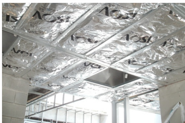
Rolac Plata Cubierta debajo de losas planas
