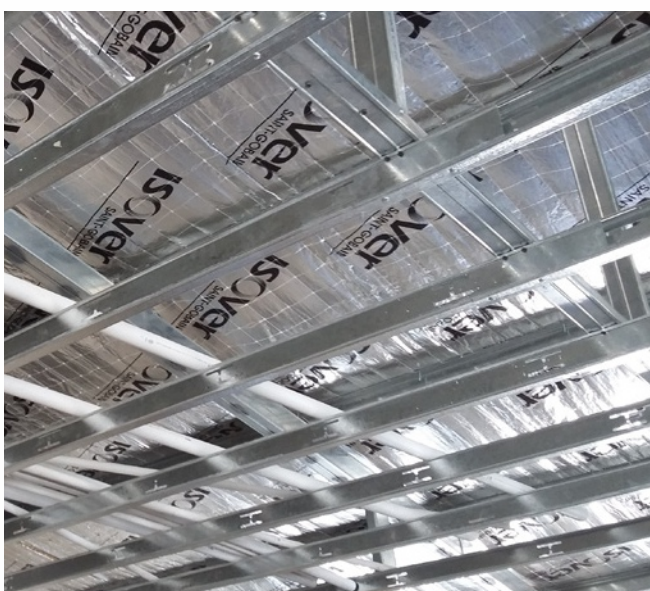
Cielorraso suspendido debajo de cubierta de chapa de pequeñas luces aislada con Rolac Plata Cubierta
