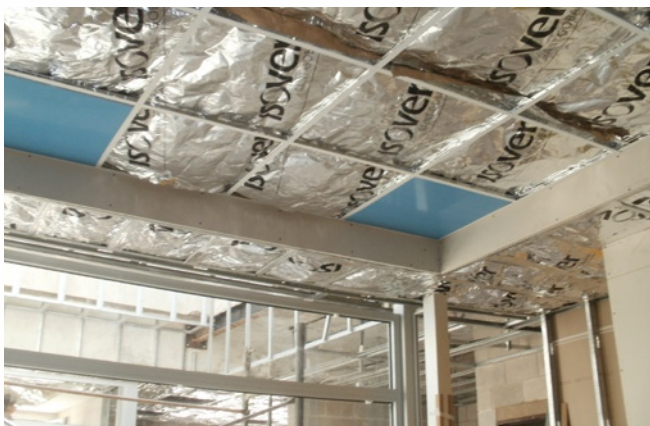
Rolac Plata Cubierta sobre cielorraso desmontable
