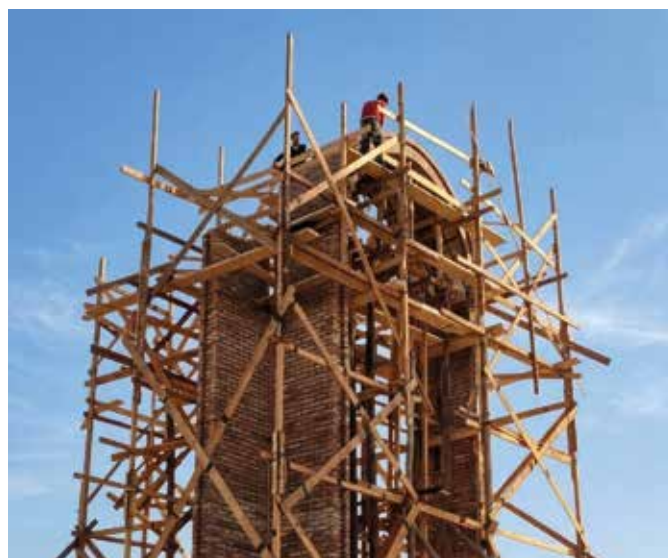
Proceso de construcción. Andamios de madera
